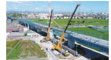
東海環状自動車工事
